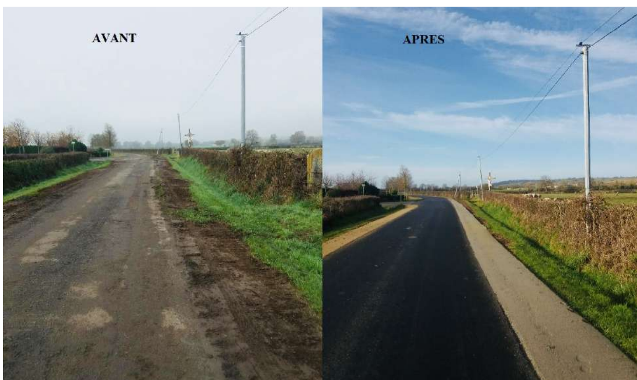
Réfection de la rue Sarreau à Saint-Pierre-les-Étieux
