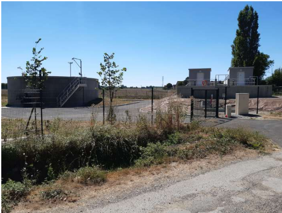
Nouvelle station d'épuration de Meillant
